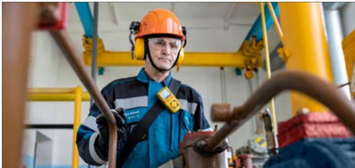
Переключение, регулировка мощности подачи газа в трубопровод и его напора – то, что Рашид Харисович ежедневно делает во время работы. А еще осуществляет замену задвижек, следит за исправностью приборов, датчиков, факельного хозяйства / ФОТО СЕРГЕЯ ТРУСОВА
